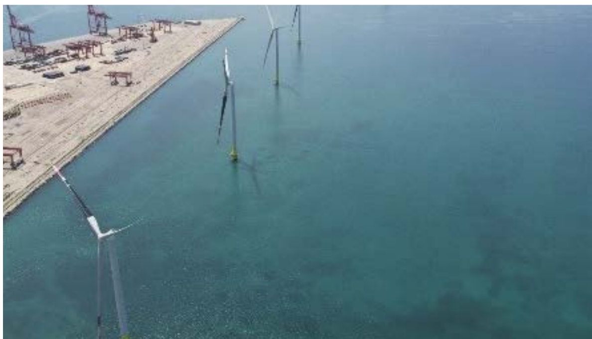
Ripresa aerea del parco eolico
