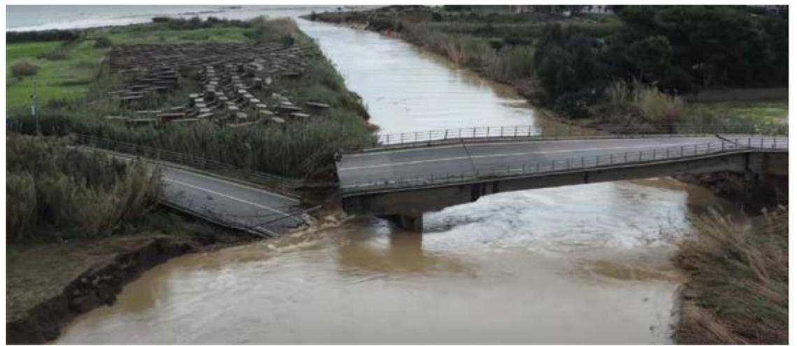
**Figura 3.** Fiume San Bartolomeo, ponte della SS 187 a Alcamo (TP). Un evento di piena del 2021 ha causato erosione della sponda, con conseguente cedimento della struttura. (<https://www.youtube.com/watch?v=PK3qkopM7es>)
