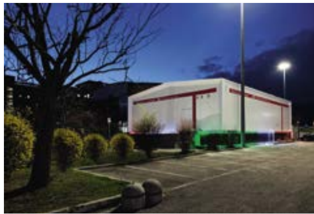
Conclusione dei lavori
