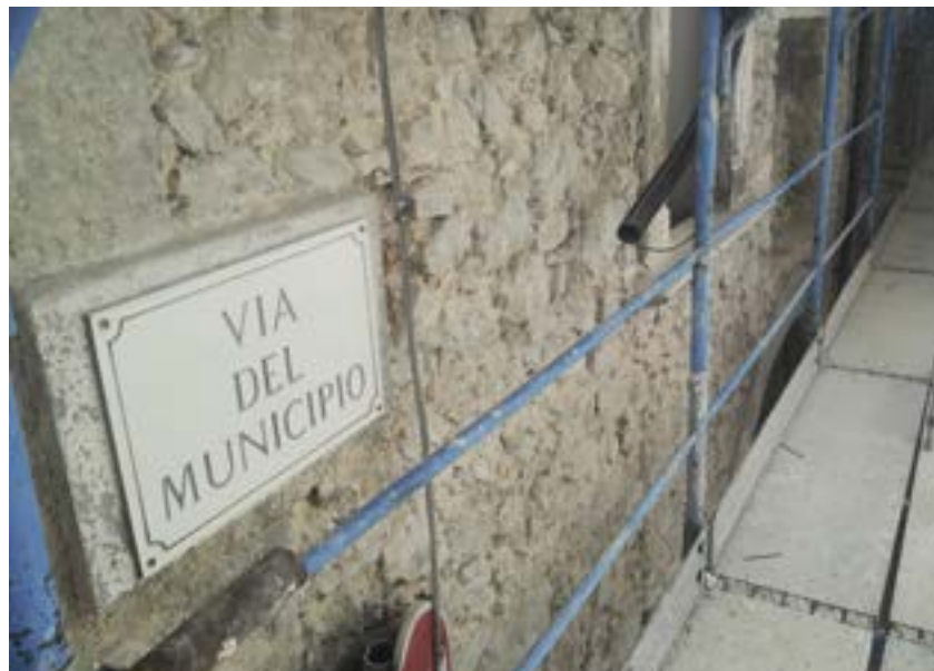
Messa a nudo della muratura portante
