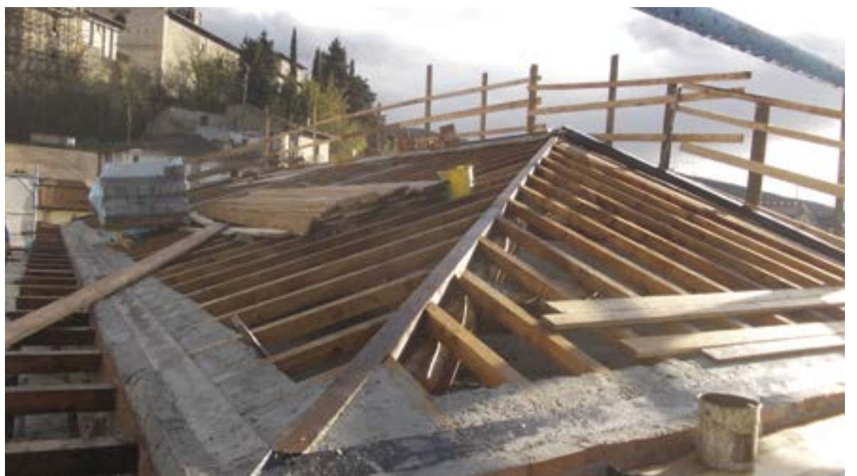
Nuove coperture in legno
