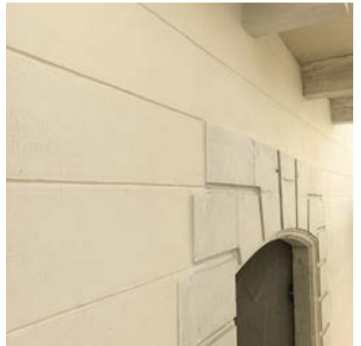
Fasce d'intonaco e imbotti in pietra
