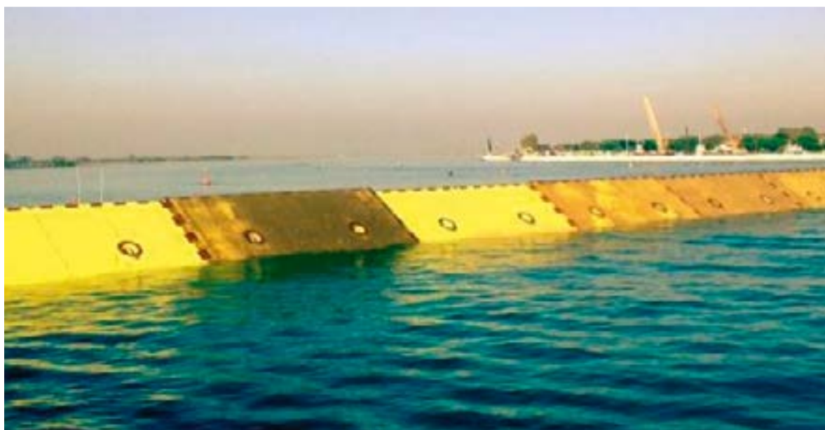
Fig. 2 – Il MoSE a Lido-Treporti: schiera di paratoie sollevata durante una delle recenti prove di funzionamento (Fonte: Consorzio Venezia Nuova)
