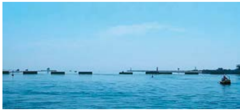
Fig. 5 - MoSE: la barriera di Malamocco in fase di chiusura (ore 11:30 del 10 luglio 2020)
