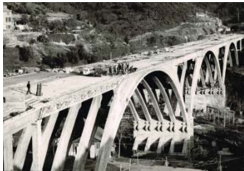
Autostrada Genova-Savona, viadotto Ruscarolo, "Ponte drago" a tre arcate a cinque nervature ciascuna di 80 metri di luce a tre cerniere elastiche (anni 1962/63)
