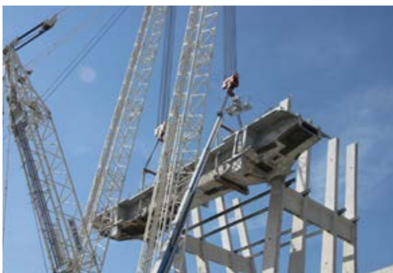
La fase di smontaggio del Ponte Morandi
