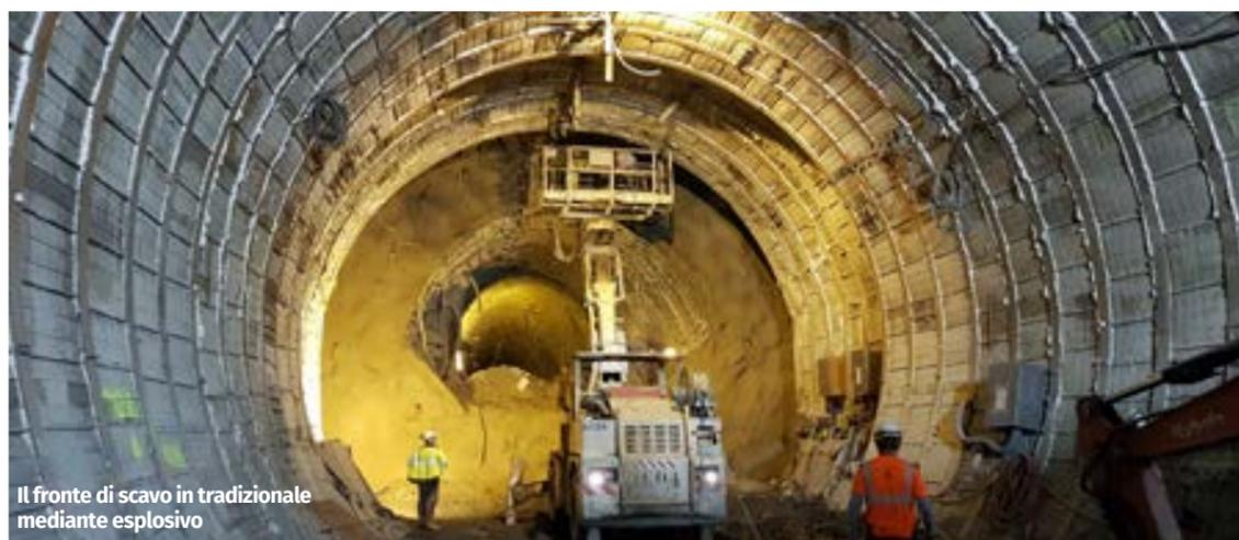
Il fronte di scavo in tradizionale mediante esplosivo
