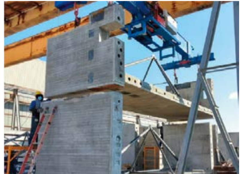
Figura 9. Posizionamento dei conci nell'area di stoccaggio
