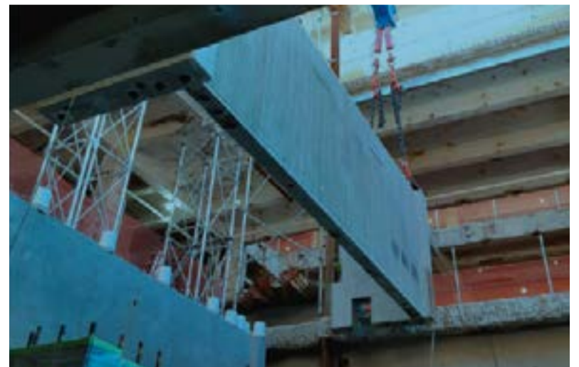
Figura 10. Fase di posizionamento di un conio
