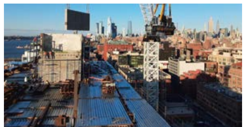
Figura 11. Completamento in quota di un "core"
