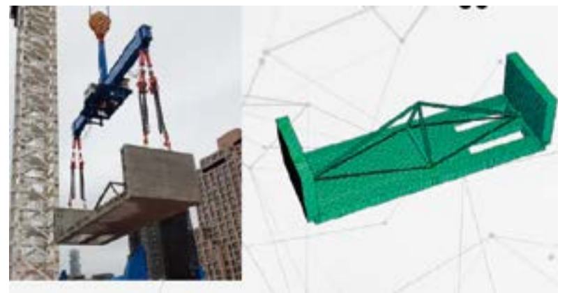
Figura 7. Fase di movimentazione di un conio
