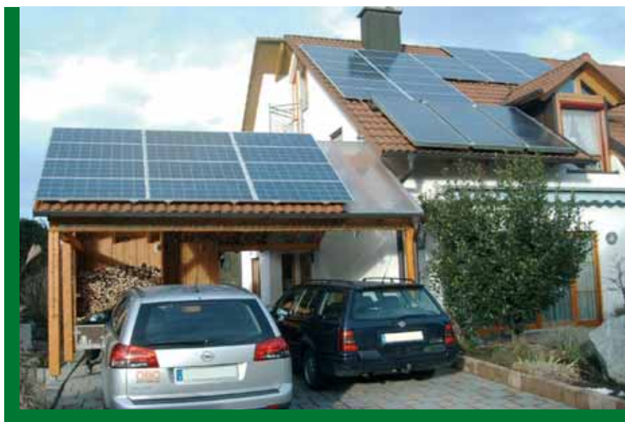
Esterno 1: installazione su tetto a falde inclinate
