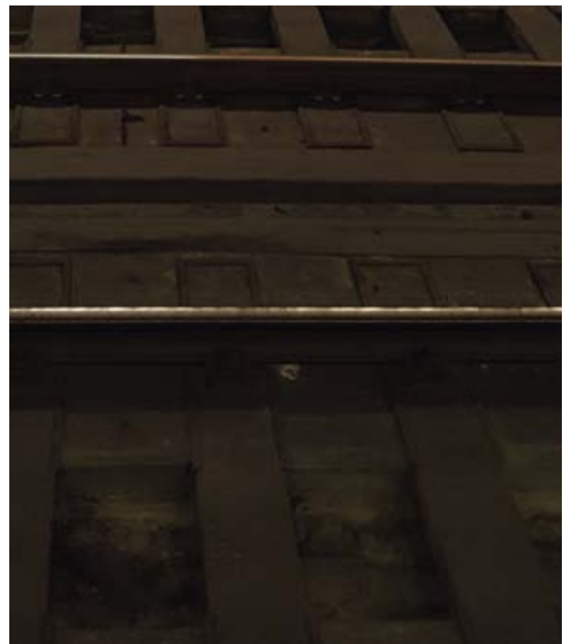
Figura 5. Sulle rotaie della stazione Moscovia della linea M2 di Milano si vedono i tratti con diversa luminosità della luce riflessa dalle lampade della banchina opposta. La diversa riflessione è dovuta alla mazzatura e si possono contare all'incirca 10 avvallamenti (con maggiore riflessione della luce) di mazzatura su un tratto di rotaia di circa 70 cm tra due traversine. Quindi la lunghezza d'onda della mazzatura è di circa 7 cm
