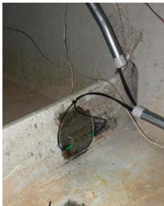
Estensimetri a fibra ottica che controllano le deformazioni a cui è soggetto l'impalcato del ponte (immagine fornita da CETENA).
