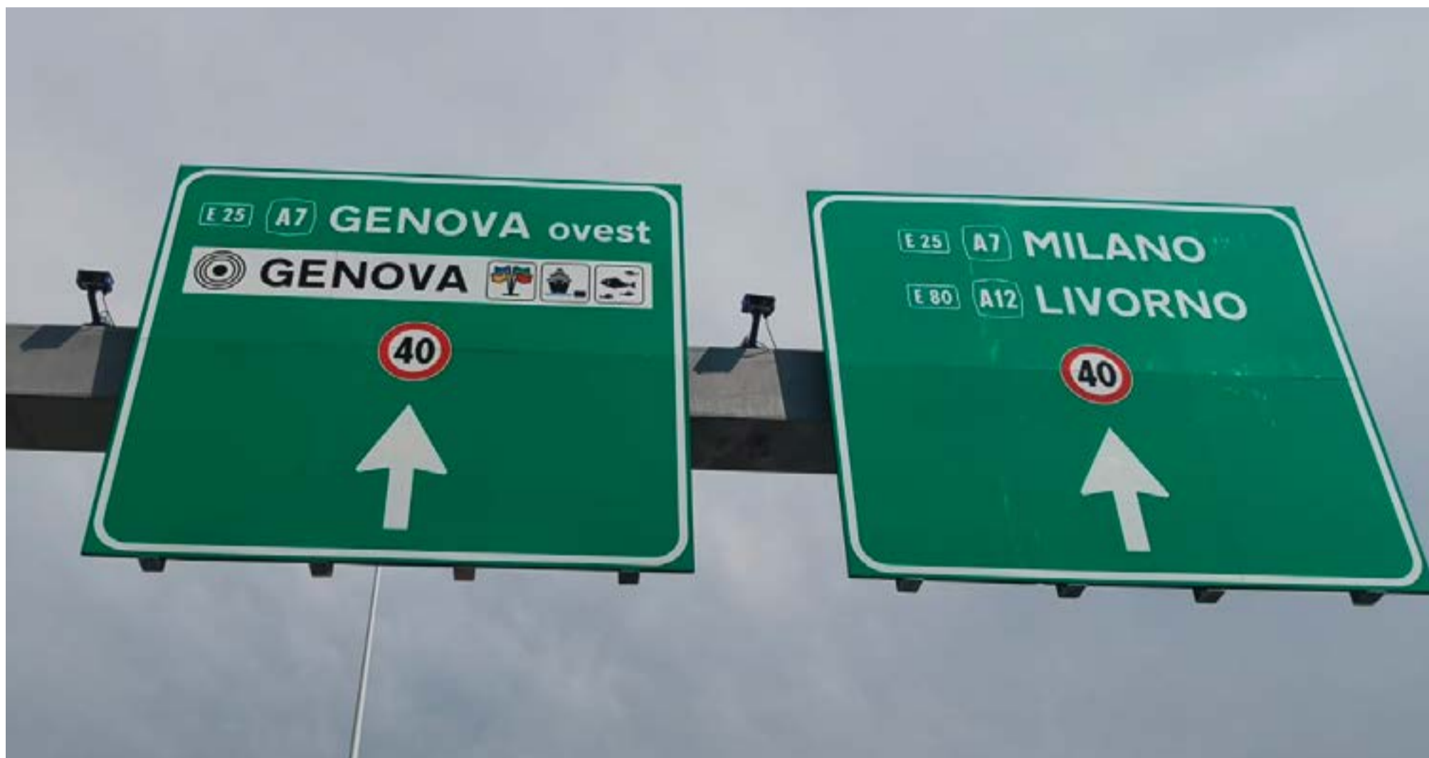
Telecamere a supporto del sistema "iWIM Bisonte" per l'individuazione dei veicoli (immagine fornita da CETENA).
