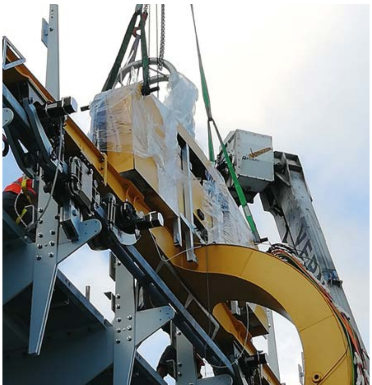
Particolare dell'aggancio del braccio meccanico del robot-inspection alla parte esterna del ponte percorsa da rotaia (immagine fornita da IIT - Camozzi).
