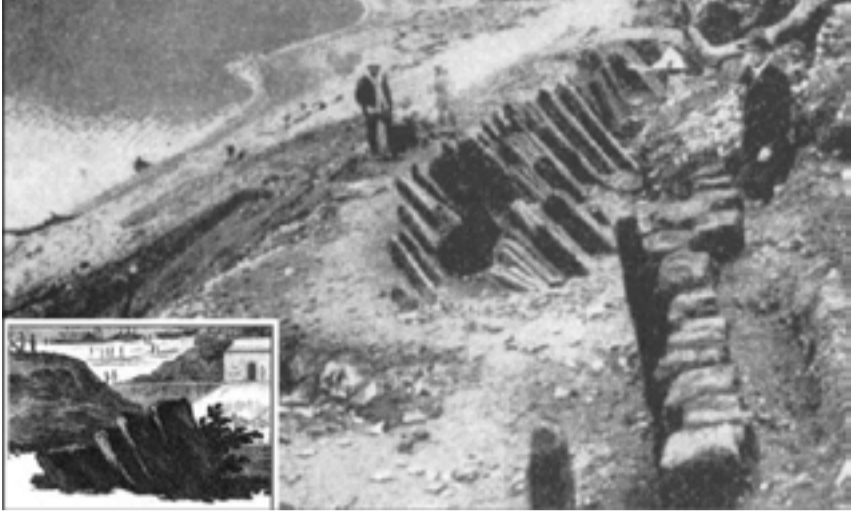
Figura 1. Immagine tratta da F. La Greca, Noterelle pestane. I porti di Paestum nel Medioevo e una ipotesi sul porto romano, in Annali Storici di Principato Citra, XII, 1, 2014, pp. 33-59; in grande il rinvenimento nel Lago di Nemi del 1929/1930, in piccolo l'incisione di François Morel del 1810.
