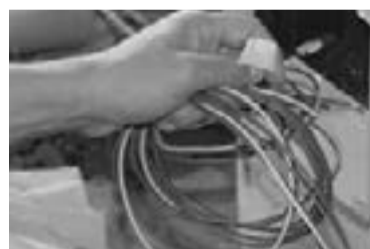
FIG 5b. Cablaggio del sistema di monitoraggio
