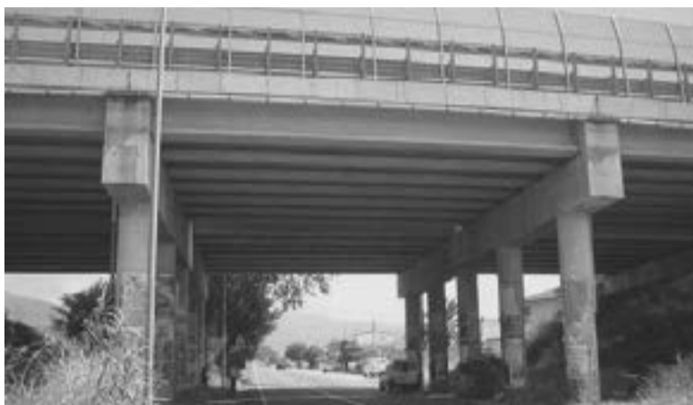
FIG 3. Immagine del viadotto prima dell'intervento di adeguamento sismico
